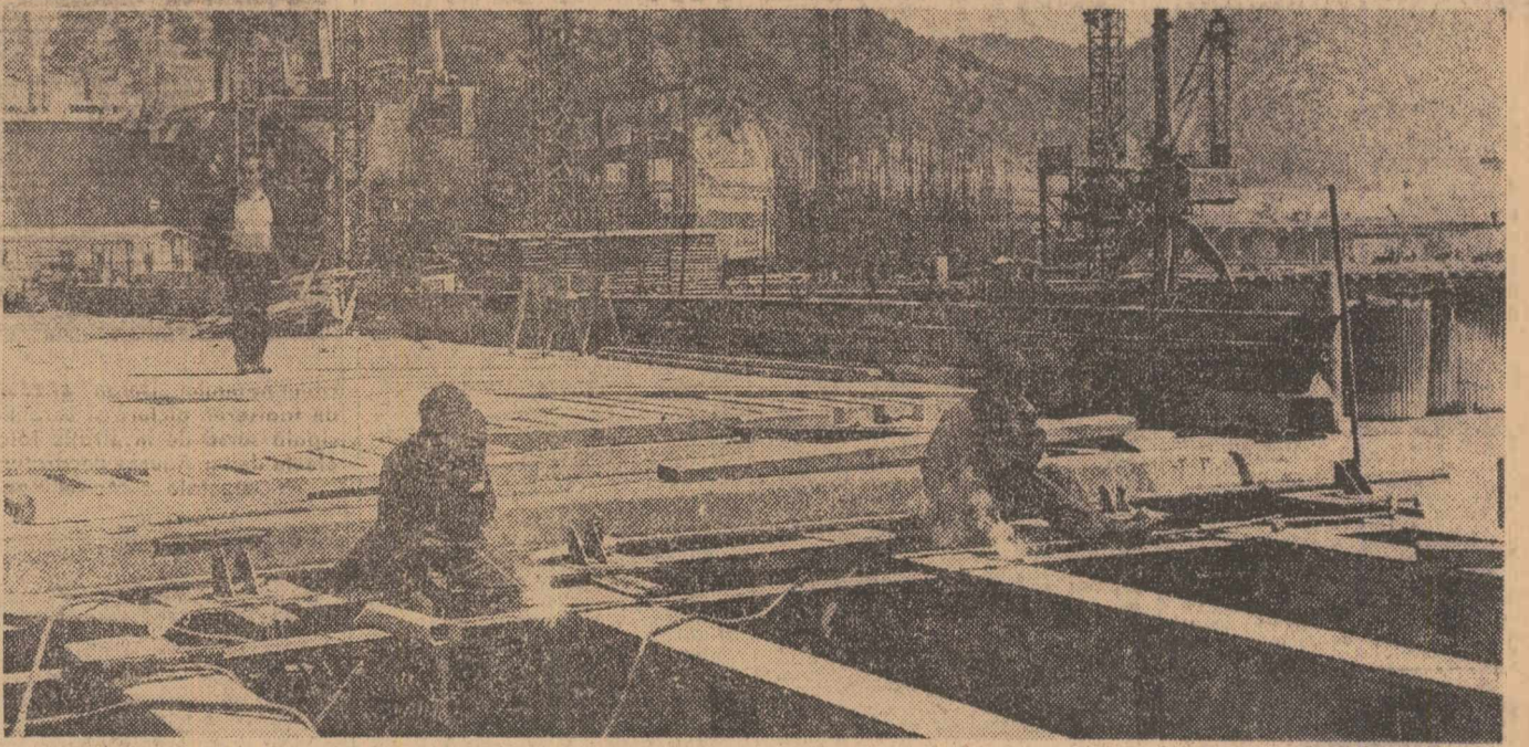
Deasupra vîrtejurilor Dunării, sudorii din echipa lui Ion Baltag lucrează la montarea ferelor care susțin palplanșele podului fix cu ajutorul căruia se va efectua în luna august închiderea definitivă a albiei.
