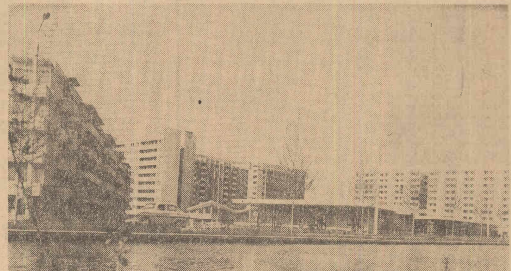
Alături de zeci de alte localități ale patriei, Tîrgu Mureș și-a croit noi dimensiuni arhitectonice, urbanistice și de civilizație. În clișeu: Blocuri de locuințe pe Aleea Carpați
