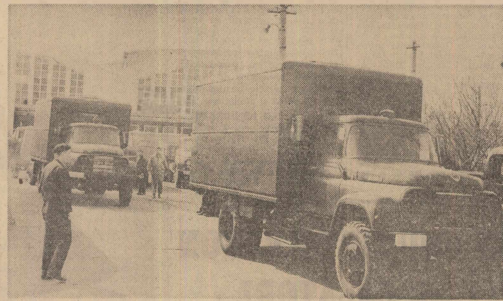
La întreprinderea de reparații auto nr. 3 București a intrat în fabricație de serie un nou produs: autobuzul extensibil dormitor. Noul produs poate fi folosit ca autoturism pe șantier, în locurile turistice, unde nu sînt condiții de cazare etc. Se compune dintr-o dubă normală montată pe autovehiculul Steaqa Roșu 115 cu posibilitatea de pliere a peretilor laterali, astfel încît să se formeze încă două camere avînd o capacitate de 20 paturi supra-
