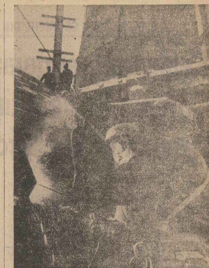
Printre constructorii care lucrează la înălțarea celui de al doilea furnal de 1700 m c ce se construiește la Combinatul siderurgic din Galați se numără și doi frați: Nicolae Foltezan, șef de echipă și sudorul Vasile Foltezan, lăcăș în clișeu nostru lucrînd la asamblarea unor piese ale furnalului Foto: NICU VASILE
