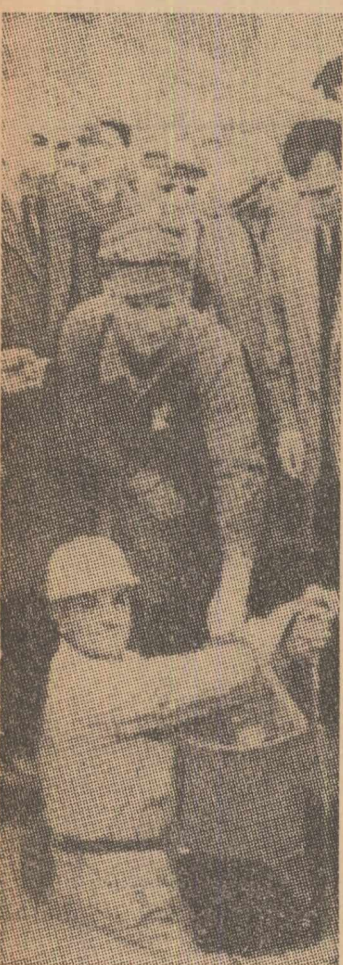
Faimoasele Hale Centrale din Paris, considerate ca fiind mai mare piață din Europa, au părăsit capitala franceză, cu începere de la 3 martie a.c., cu excepția citorva pavilioanelor. Noul amplasament al actualei piețe este la Rungis, o mică comună situată la 15 km de Paris. O dată cu mutarea pieței, a început, însă lupta împotriva șobolanilor care trăiesc în cartierul din apropierea hălelor. Autoritățile au imprăștiat, în diverse locuri, drept momeală, 10 tone de boabe de grâu, otrăvite, dar parfumate, avînd miros de zmeură. În fotografie un „specialist” care coboară în subteran pentru a im-prăștia asemenea momeală.
