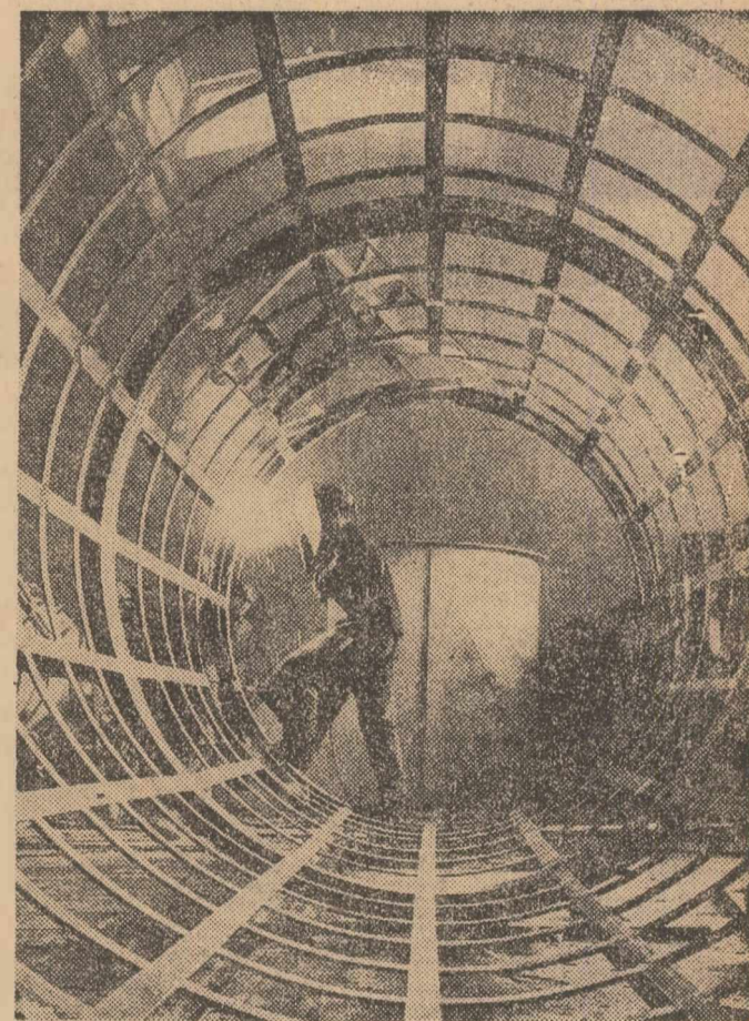
Utilizarea de noi tehnologii de fabricație, dezvoltarea și sistematizarea producției de utilaj chimic, constituie noi pași spre profilarea și specializarea Uzinei „Grivița Roșie” din Capitală, care va înzestra anual industria chimică cu peste 20 000 tone de utilaje. În clișeu: Noua hală de cazangerie în care se lucrează la asamblarea utilajului chimic destinat U.S.A.S. — Năvodari.
