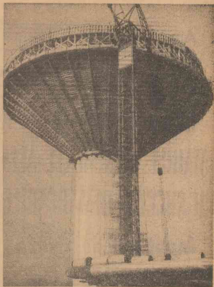
Pe șantierul uzinei de piese de schimb pentru industria chimică din Găești, își înalță, somei, contururile, castelul de apă. Foto: G. SAFTA
