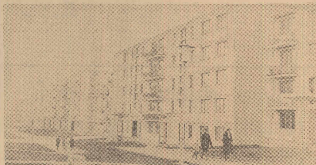
Blocuri noi de locuințe în orașul Rm. Vîlcea
