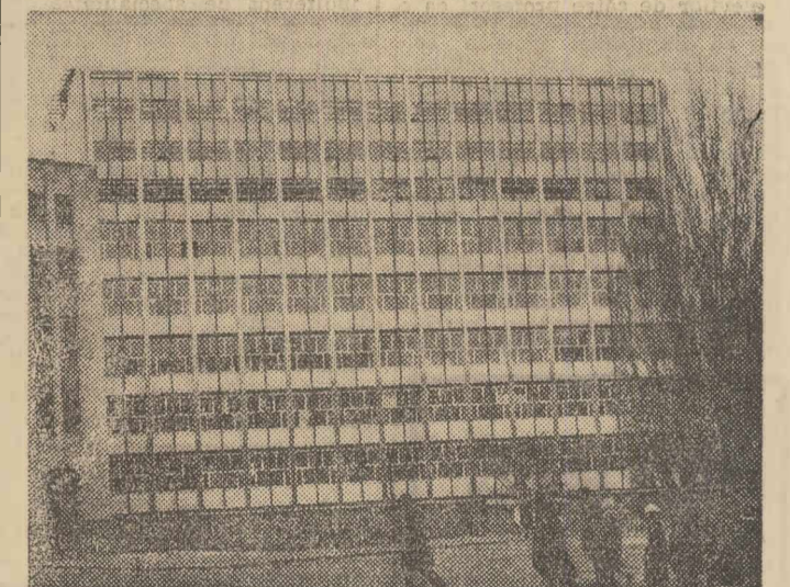
În noua aripă a palatului telefoanelor, recent construită a început montarea echipamentelor moderne pentru automatizarea liniilor telefonice interurbane Foto: O. CAHANE
