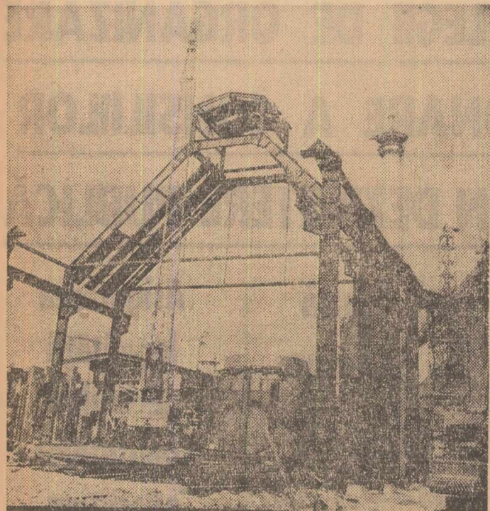
Construcția celui de-al doilea furnal de 1 700 m.c. de la Combinatul siderurgic Galați se desfășoară într-un ritm alert. Imaginea noastră vă prezintă o parte din lucrările de montare a acoperișului halei de turnare
