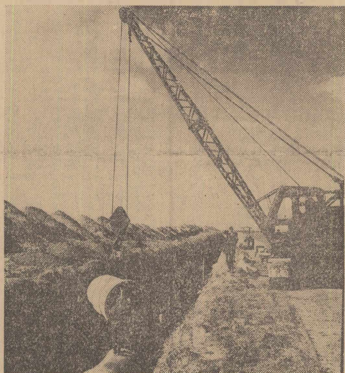
Între Arcuța și Bragadiru-Nord se desfășoară în prezent importante lucrări pentru mărirea debitului de apă potabilă, necesar noilor cartiere ale Capitalei. În cliseu: Pe șantier se execută montajul tuburilor de aducțiune
