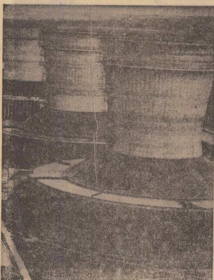
Centrala electrotomică din Craiova cuprinzând trei grupuri de câte 50 MW, două grupuri de câte 100 MW fiecare și două grupuri de 315 MW fiecare, este o „stea” de primă mărime în constelația industrială a Olteniei și a sistemului nostru energetic național. În clișeu: Bateriile turnurilor de răcire ale centralei
