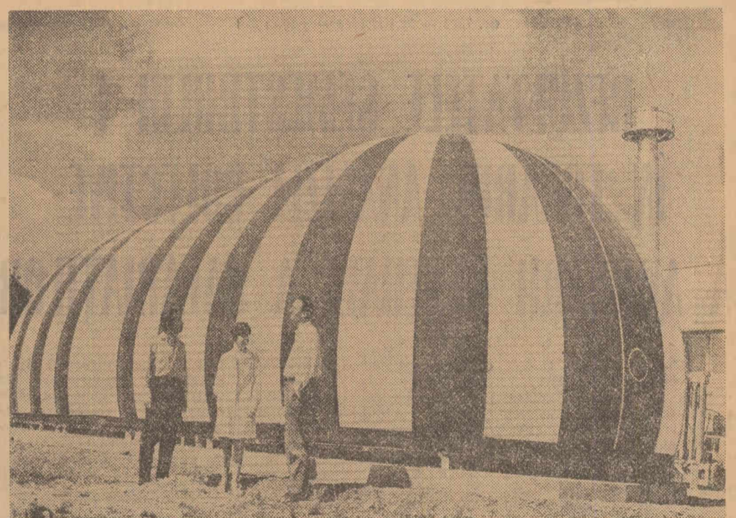
La Institutul de Fizică Atomică din București s-a terminat construcția pneumatică autoportantă, destinată adăpostirii unor montaje experimentale de dimensiuni mari. Construcția este fără stâlpi de susținere, menținerea ei făcându-se printr-o presiune interioară de aer. În clișeu: aspect exterior
