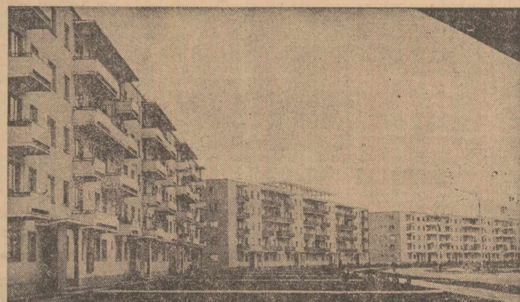
Lîngă vechea cetate din Alba Iulia, într-un loc care și-a păstrat denumirea de Platoul Romanilor se înalță siluetele blocurilor noi de locuințe. Celor 490 de apartamente construite în anii trecurți li se adaugă în acest an, alte 240 apartamente, din care o parte au și fost date în folosință
