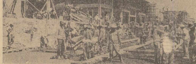
Aspect de pe șantierul complexului industrial de la Nuevitas
