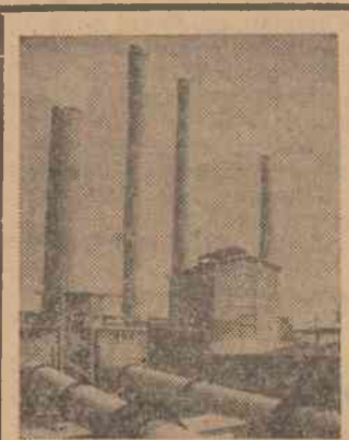
Fabrica de ciment din Fieni își îndeplinește exemplar sarcinile de plan. La sfârșitul primelor cinci luni din acest an, produsese, peste prevederi, o cantitate de 10.000 tone de ciment. În alăturare: vedere a cupolelor rotative, utilaje tehnologice de bază pentru fabricarea cimentului.
