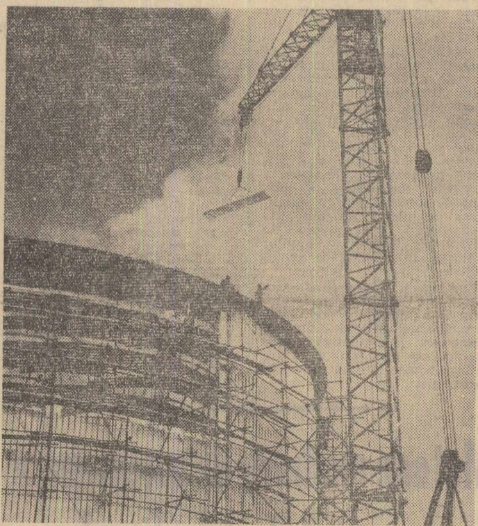
Secvență de pe șantierul Fabricii de zahăr din Oradea: lucrări de finalizare a unui din cele trei silozuri de zahăr
