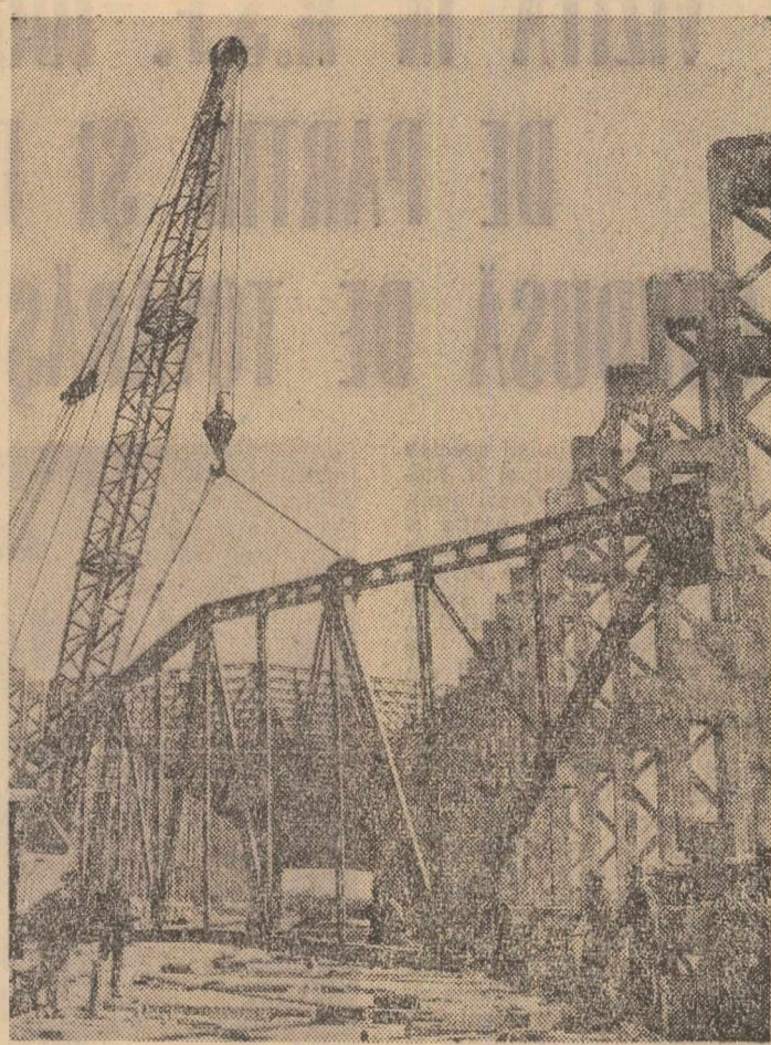
Uzina de aluminiu din Slatina a intrat în etapa III-a de dezvoltare. Urmind tradiția creată pe acest șantier, constructorii și montorii execută în avans lucrările de închidere a noii hale de electroliză.
