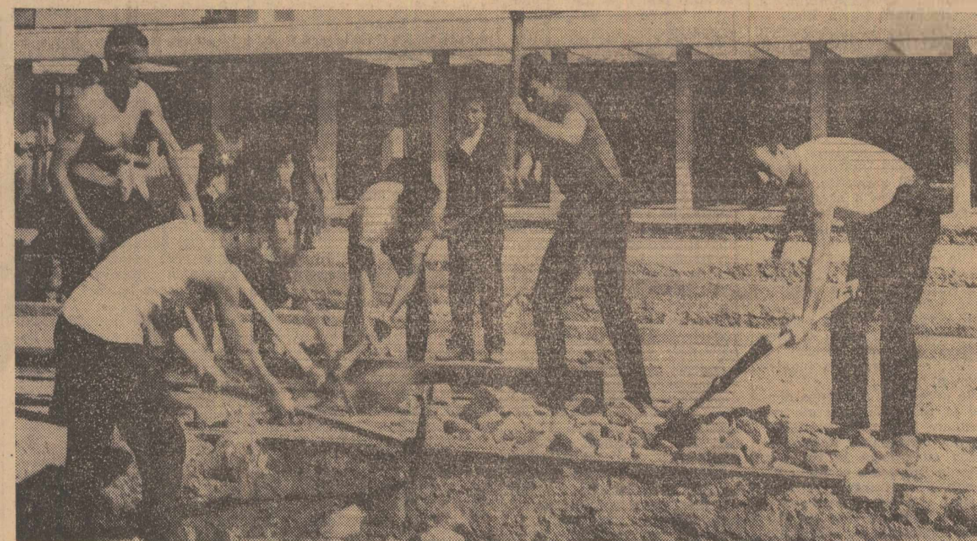
Tinere energii pe Bulevardul Păcii din Capitală, acolo de unde pornește autostrada București—Pitești.
