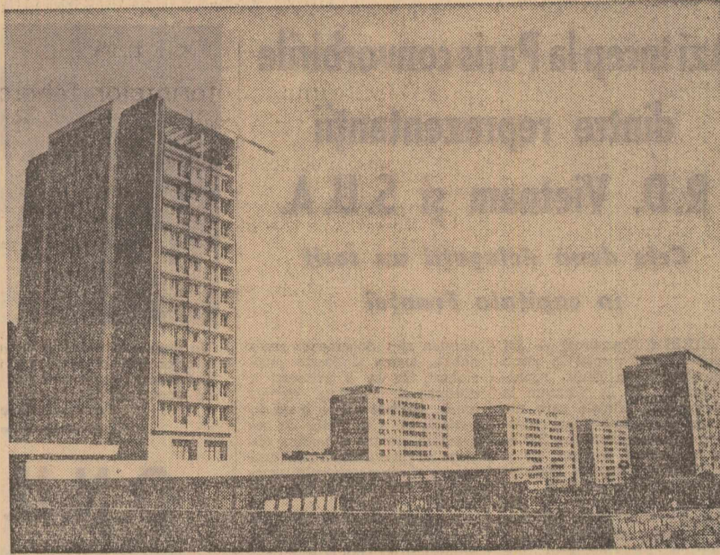
Construcții noi la Piatra Neamț
