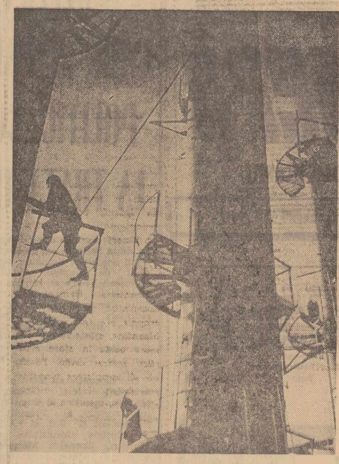
Prind contur coloanele secției de extracție și rafinare aromate de pe șantierul rafinării din Pitești. Într-un stadiu avansat se află de asemenea secția de separare xilen. Rafinăria din Pitești — acest important obiectiv industrial — va intra parțial în funcțiune în cursul anului viitor
