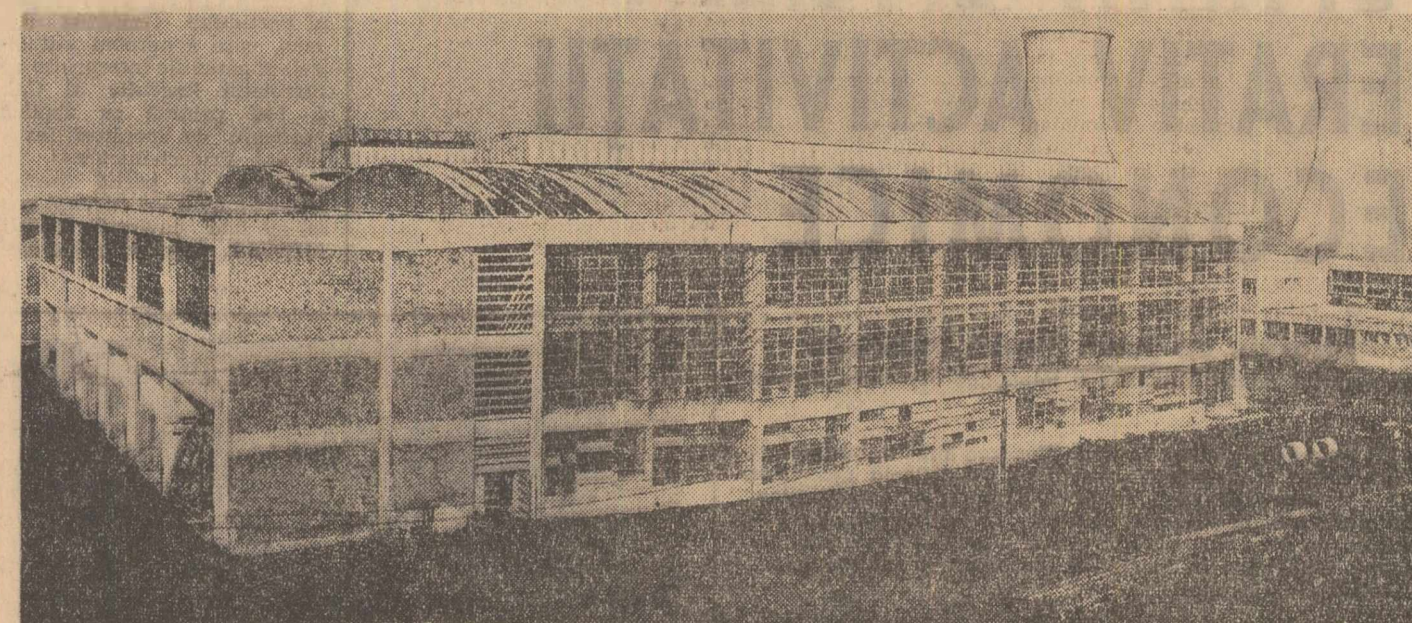
Pe șantierul Combinatului chimic de la Rimnicu-Vilcea sînt în plină desfășurare lucrările la obiectivele care vor intra în funcțiune în acest an. Dintre acestea, primul este fabrica de produse clorosodice, a cărei imagine v-om prezenta și care va fi pusă în funcțiune în trimestrul II.
