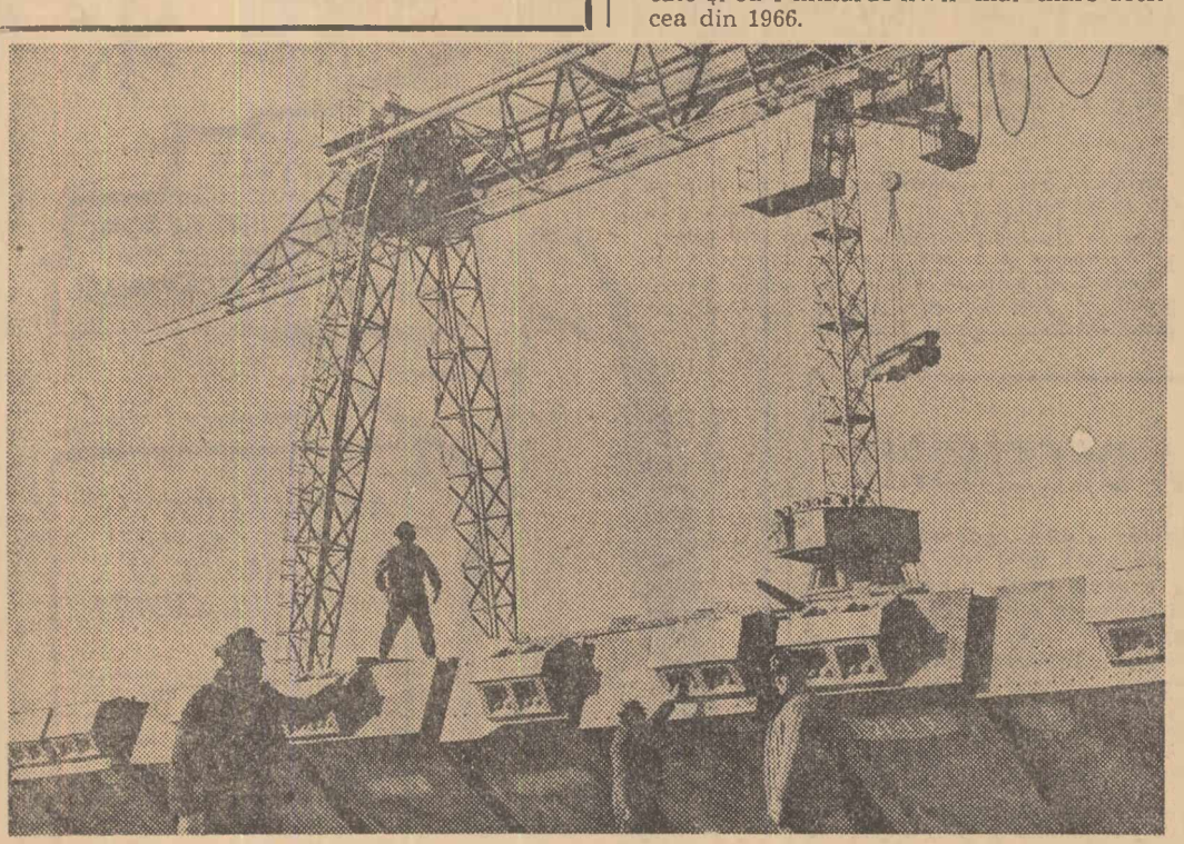
Zilnic pe adresa șantierului de la Porțile de Fier sosesc de la furnizori numeroase echipamente necesare realizării importantului obiectiv hidroenergetic. În clișeu: O echipă de la depozitul central al șantierului în timp ce recepționează o serie de tronsoane pentru ecluza de la poarta aval
