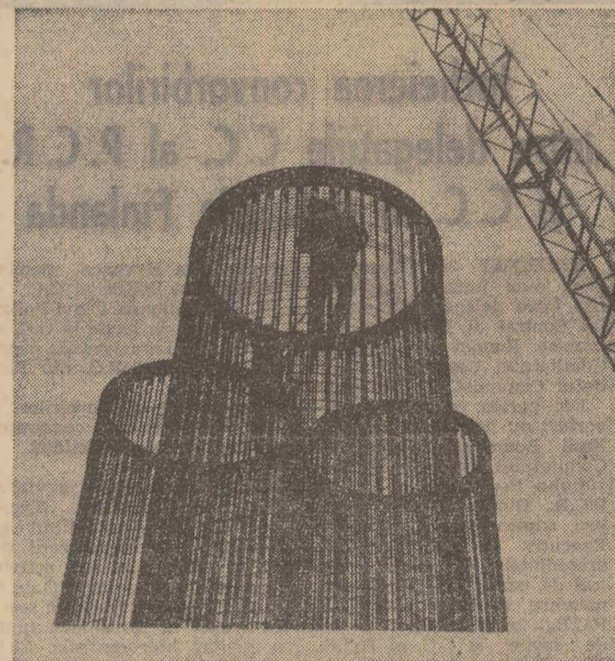
De curînd, la punctul Vadul Oii, unde se construiește un pod peste Dunăre, au început lucrările de construcție pe celălalt mal al fluviului. În cliseu: Pregătirea carcaselor metalice în vederea turnării coloanelor din beton înalte de 8 metri și cu un diametru de 3 metri.
