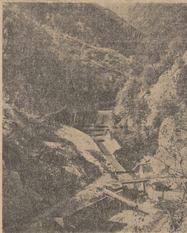
În Valea Doftanei a început construcția barajului Paltinul. În spatele a 300 000 m.c. de beton se vor acumula 56 milioane m.c. de apă, servind în principal pentru asigurarea necesităților de alimentare cu apă industrială și potabilă a zonei orașului Ploiești. Apa va fi folosită de asemenea la irigația unor terenuri agricole însumind 23 000 ha. În câmp: Vedere a lucrurilor unde se desfășoară lucrările.
