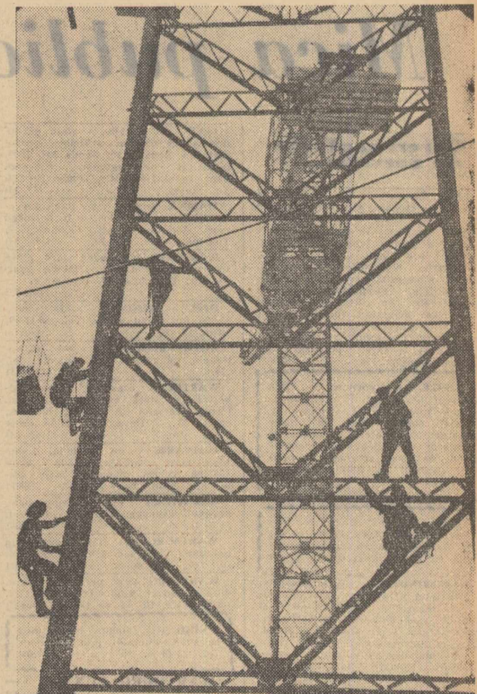
Termocentrala Craiova. De la înălțimea de zeci de metri a estacadei pe care, cu grația și siguranța unor acrobați o asemblează montorii, cărbunele va aluneca către puternicele agregate termoelectrice.
