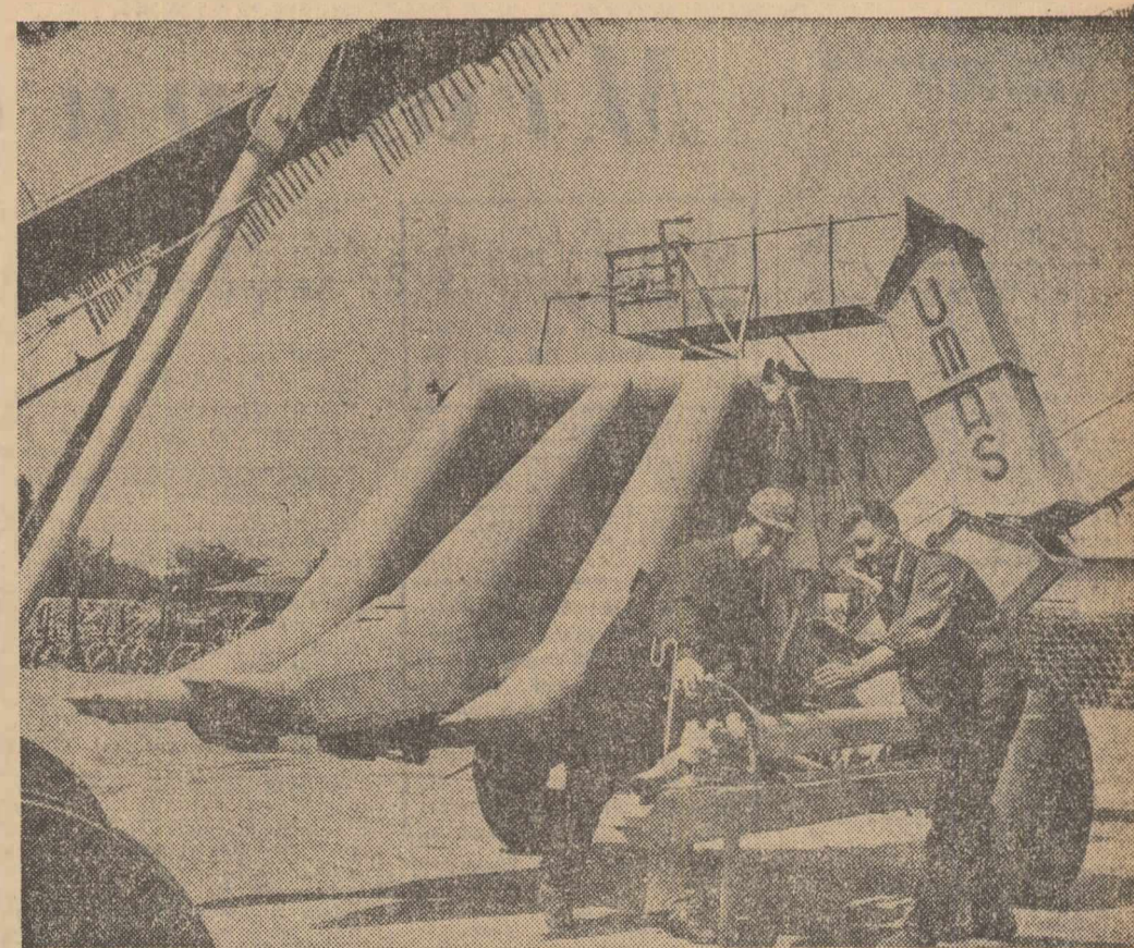
Cultura porumbului promite, în multe regiuni, o producție bună. Pentru recoltarea mecanizată a unor suprafețe cit mai mari, constructorii de combine fac pregătiri intense. La sectorul III montaj al uzinei „Semănătoreasa” se pun la punct, în serie, combine de recoltă porumb C.T.2 R.P. care, în comparație cu utilajele similare fabricate pînă acum, se prezintă cu caracteristici tehnice funcționale îmbunătățite. În cișeu: O ultimă verificare a combinei înainte de a primi viza de ieșire pe porta uzinei.
