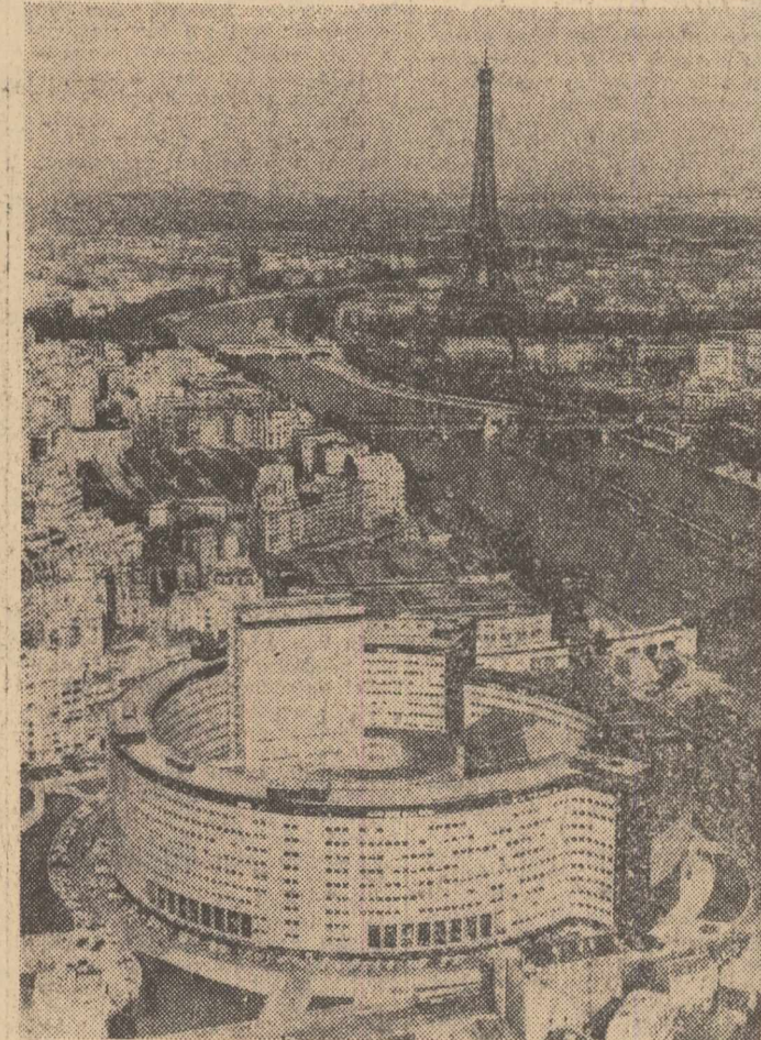
După Luvru, după Marele Palat și Palatul Chailiot, Casa Radiodifuziunii și Televiziunii Franceze (O.R.T.F.) constituie unul dintre cele mai remarcabile edificii ale Parisului, așezate pe malul Senei.
