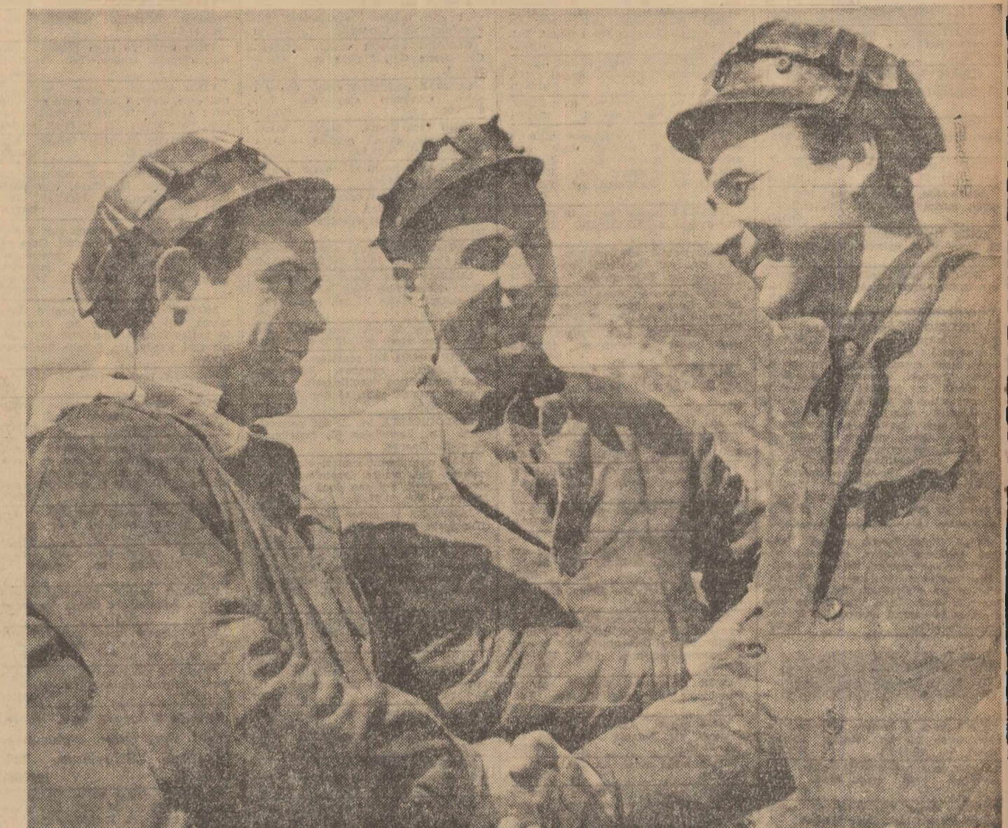
Primul și ultimul venit pe șantierul de la Ciunget, ambii vechi prieteni de muncă de la Argeș, ca și inginerul, de altfel...
