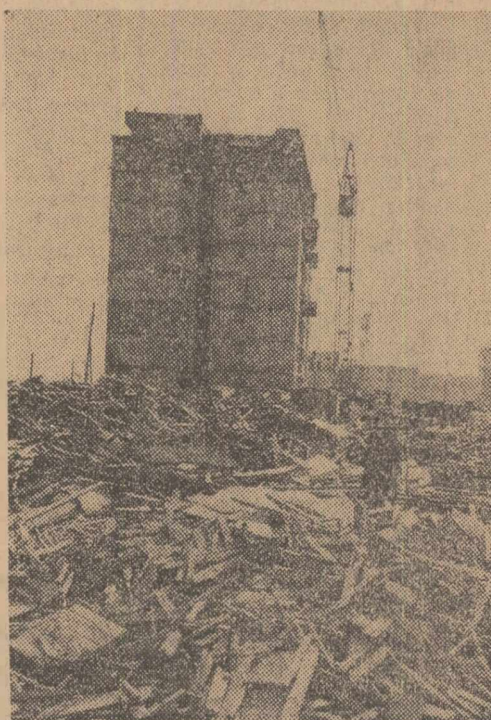
În absența spiritului gospodăresc, creșterea stivele de materiale degradate (șantierul blocului D1, constructor I.C.M.I.). Foto: MIHAI POPESCU
