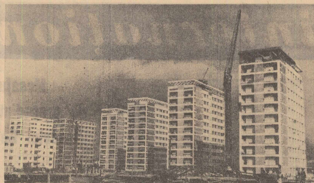
Blocuri noi pe bulevardul Ion Șulea din Capitală
