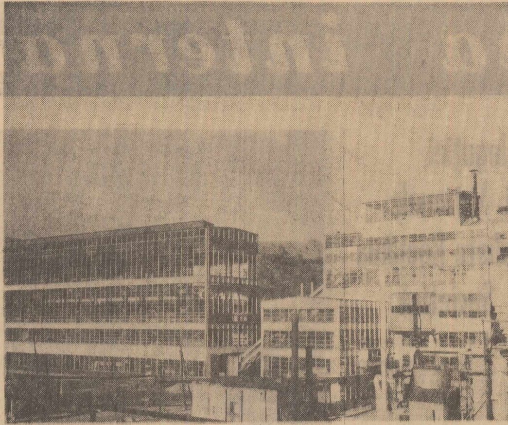
După mai puțin de cinci luni de zile de la intrarea în funcțiune, noua instalație de prelucrare a concentratorului plumbo-zincos din cadrul Uzinei chimico-metalurgice de la Copșa Mică — de unde vă prezentăm o imagine — lucrează la capacitatea proiectată.
