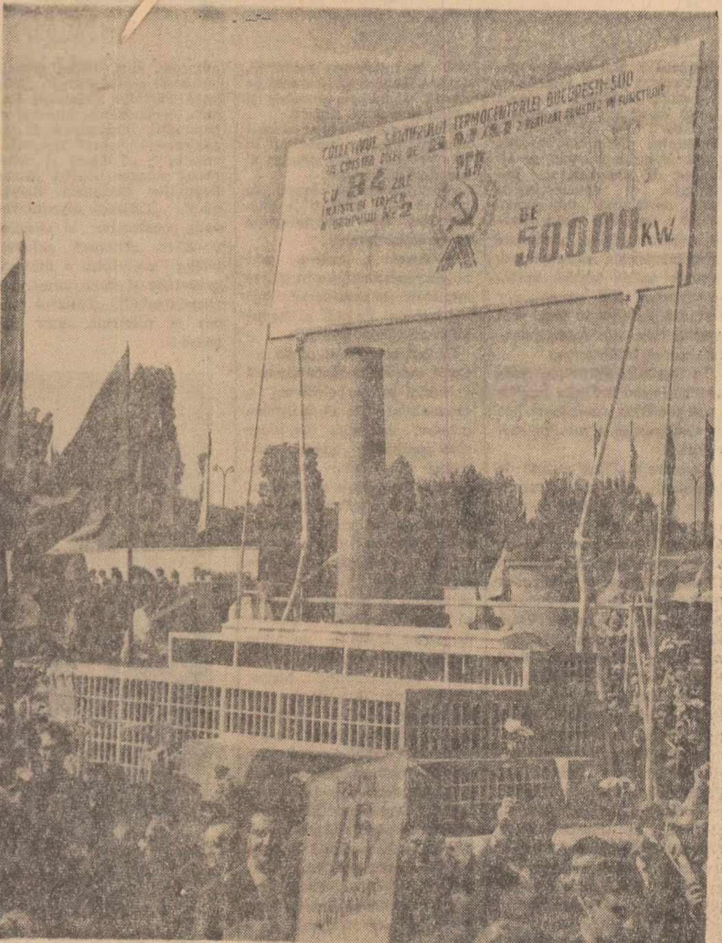
Intimpinînd glorioasa aniversare a partidului, constructorii termocentralei București-Sud raportează îndeplinirea unui important angajament: punerea în funcțiune cu 94 zile înainte de termen a grupului nr. 2.
