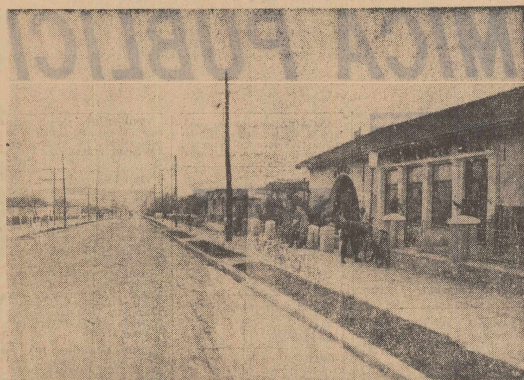
Sistematizarea satelor constituie o preocupare de seamă pentru organele locale ale puterii de stat. Iată un aspect din comuna Cruci, regiunea Dobrogea, care înfățișează o serie de noi construcții, inclusiv a unui magazin mixt al cooperăției de consum, aliniate perfect de-o parte și de alta a șoselei.
