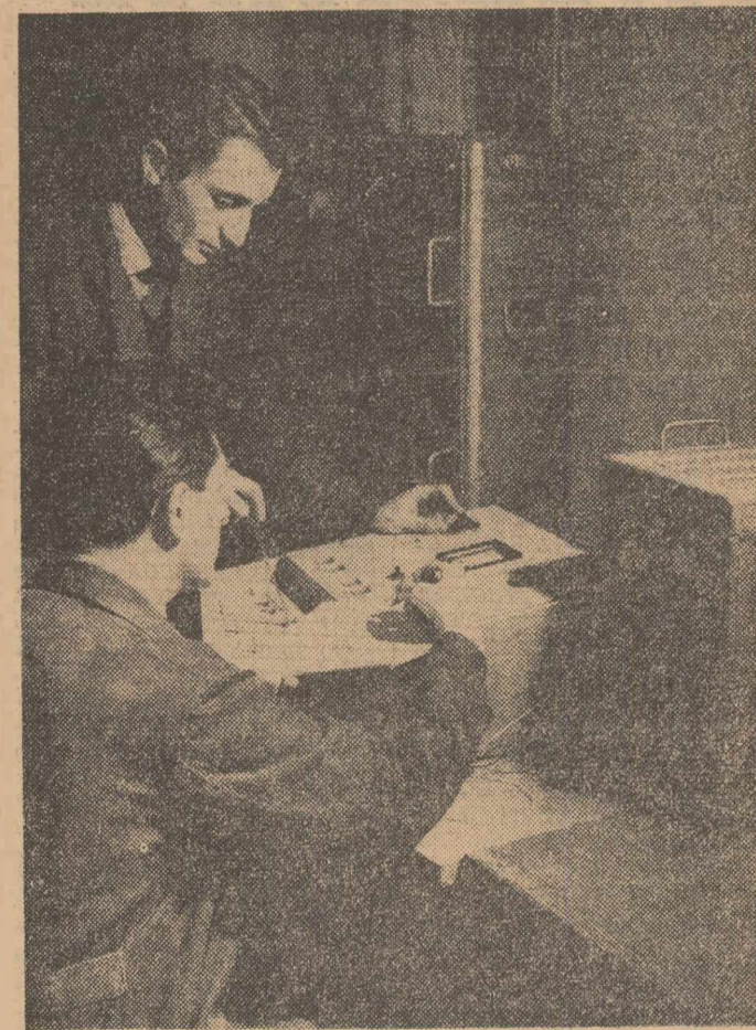
La Întreprinderea pentru raționalizarea și modernizarea instalațiilor energetice se realizează o parte din aparatul necesar întreținerii și exploatarei sistemului energetic al țării. Totodată aici se fac studii și cercetări privind aparate noi folosite la automatizarea proceselor de producție, instalații pentru centrale electrice. În cișeu: tehnicienii Mircea Viad și Ioan Florescu, de la serviciul automatizării al sistemului energetic, lucrînd la montarea unui dispozitiv pentru pornirea și oprirea automată a hidrogeneratoarelor necesare centralelor de pe Bistrița. Foto: AGERPRES
