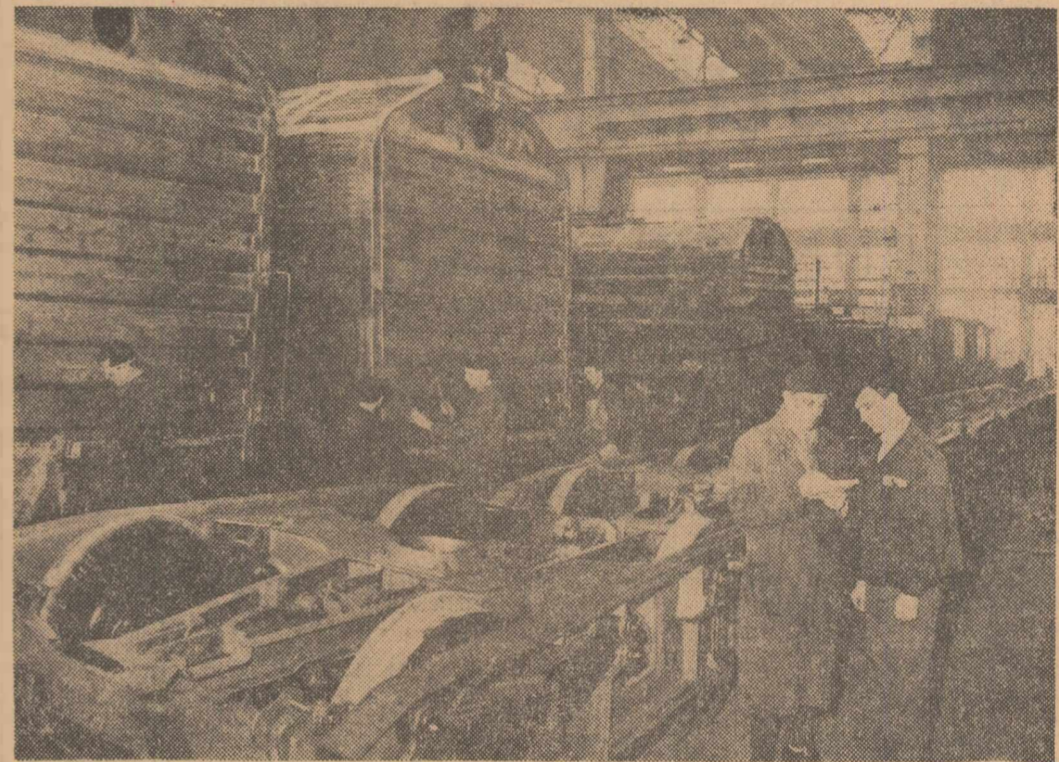
La Uzinele de vagoane din Arad, fabricația vagonului gondolă a fost organizată în flux tehnologic continuu. Construcția completă a dat și noile condiții de lucru asigură executarea unui vagon de 60 de tone în numai două ore și jumătate. Rezultatele dobândite în perfecționarea organizării producției la acest vagon au determinat conducerea uzinei să studieze posibilitatea trecerii la fabricarea în flux pe tace și a altor tipuri de vagoane. În cișeu: Vedere din hala de montaj a vagoanelor de marfă
