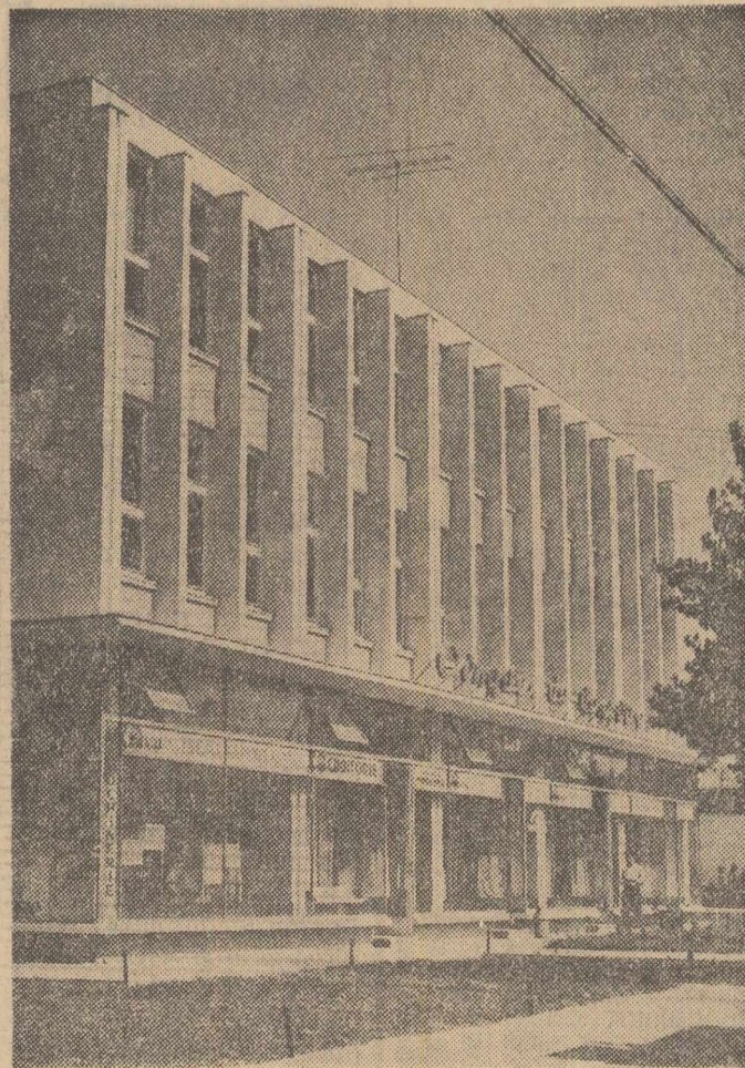
Complexul de servicii a populației din orașul Alexandria recent construit
