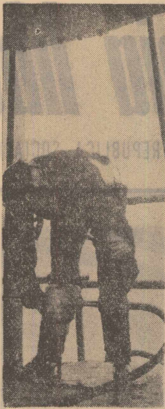
Pentru ca podurile dunărene din zona Fetești-Cernavodă să corespundă cerințelor actuale ale traficului feroviar...
