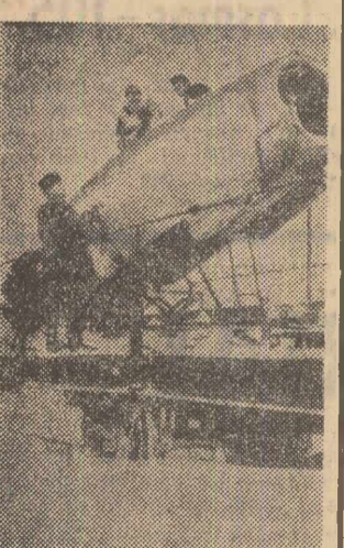
acoperit linia ferată, se face cu ajutorul unui avion cu reacție.
