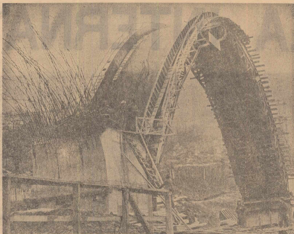
La Porțile de Fier se construiește o nouă linie ferată. În cliseu: Unul din viaductele în construcție care va avea o lungime de 235 metri cu 6 bolți
