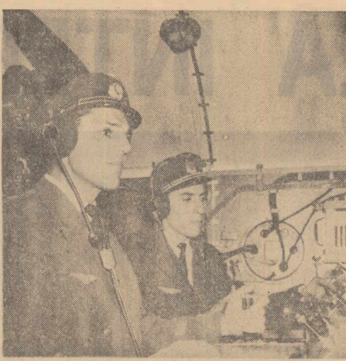
Stația de radiolocație de la aeroportul Băneasa contribuie la asigurarea integrității zborului. În clădire: operatorii M. Bejan și Gh. Toma urmăresc pe ecran imaginea avioanelor pentru a le comunica coordonatele zborului.
