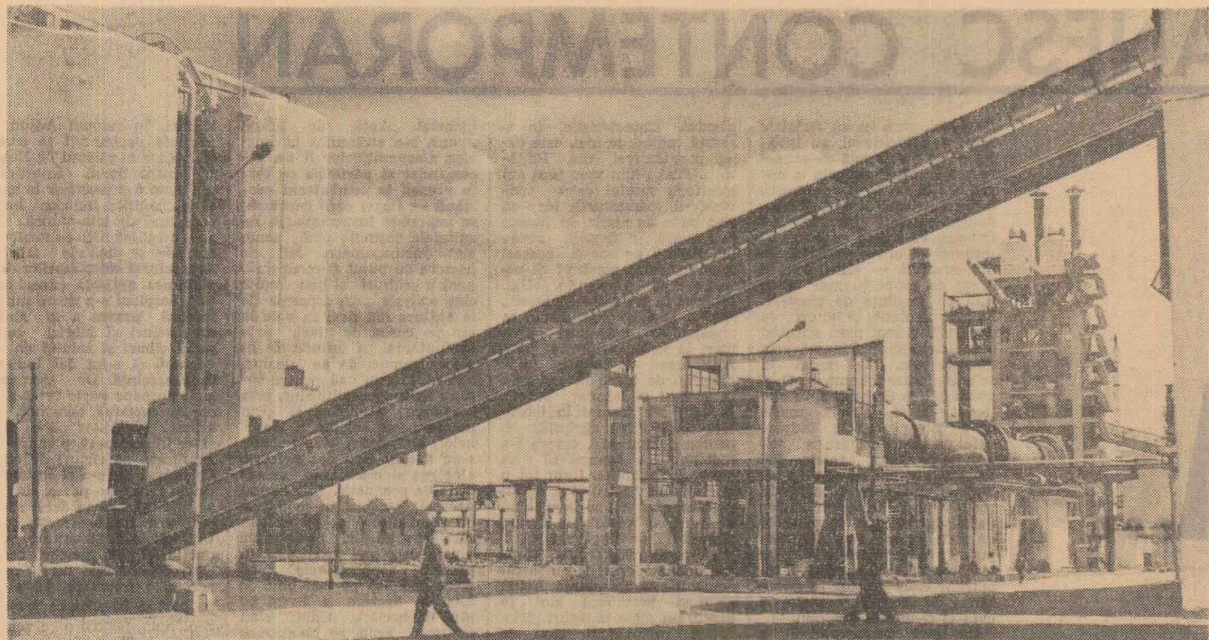
Uzina de alumina din Oradea — vedere a cuptorului de calcinare și a silozurilor de alumina calcinată Foto: NICU VASILE
