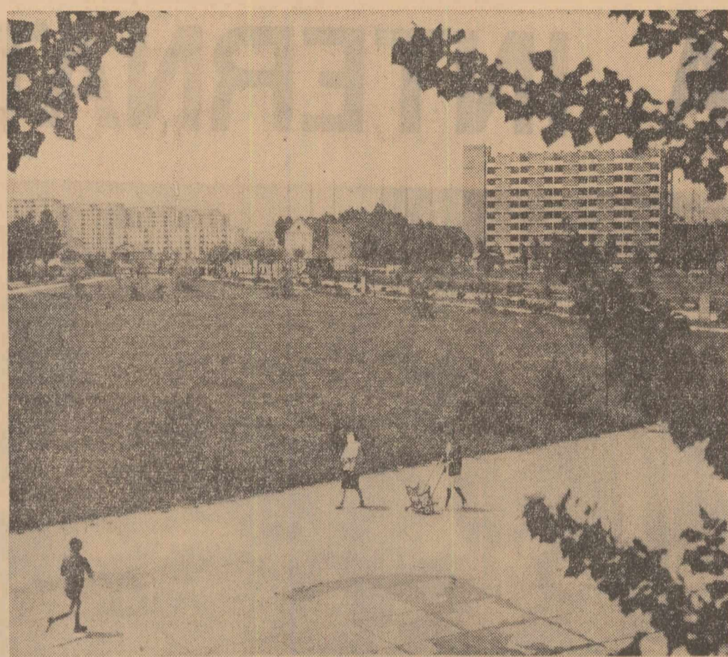
Construcții noi la Hunedoara
