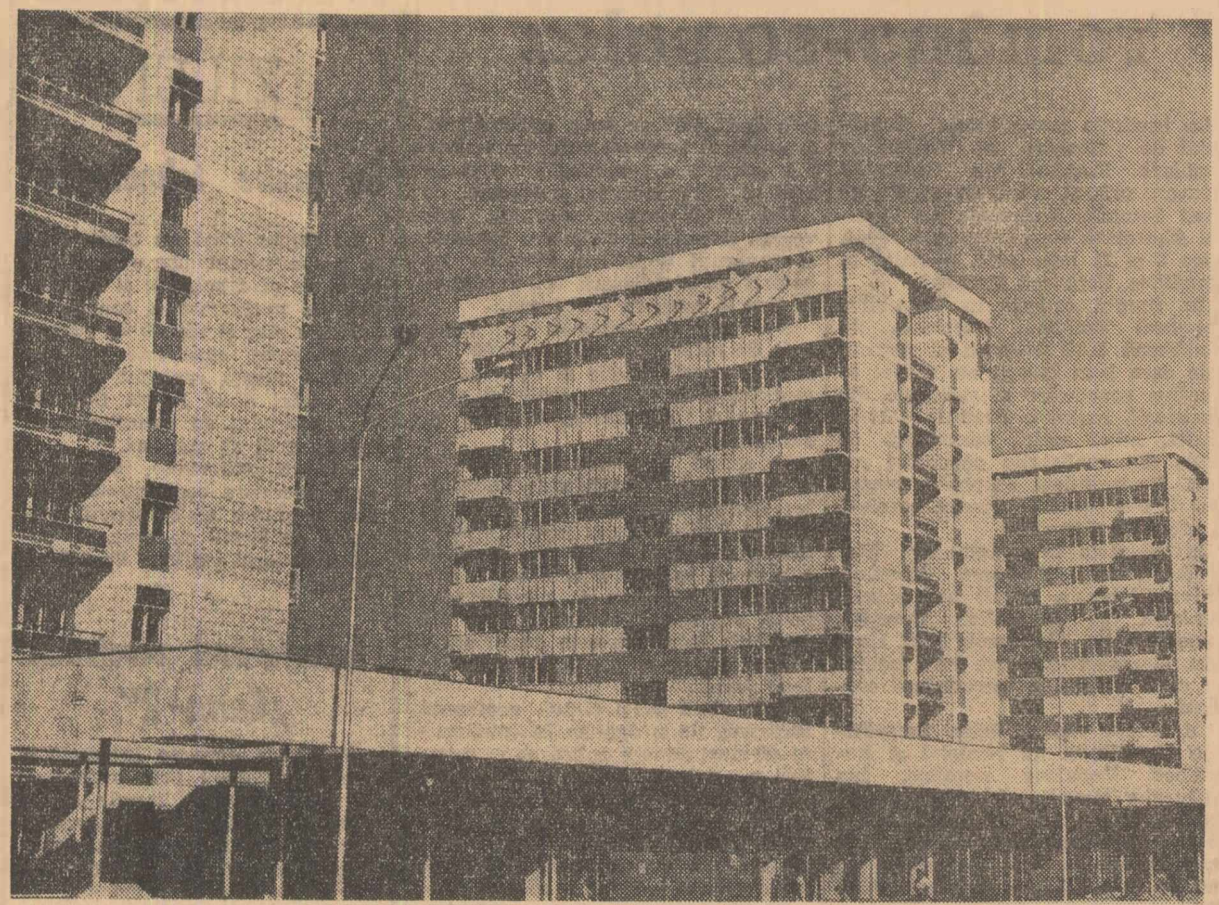
Blocuri din fața gării din orașul Bacău
