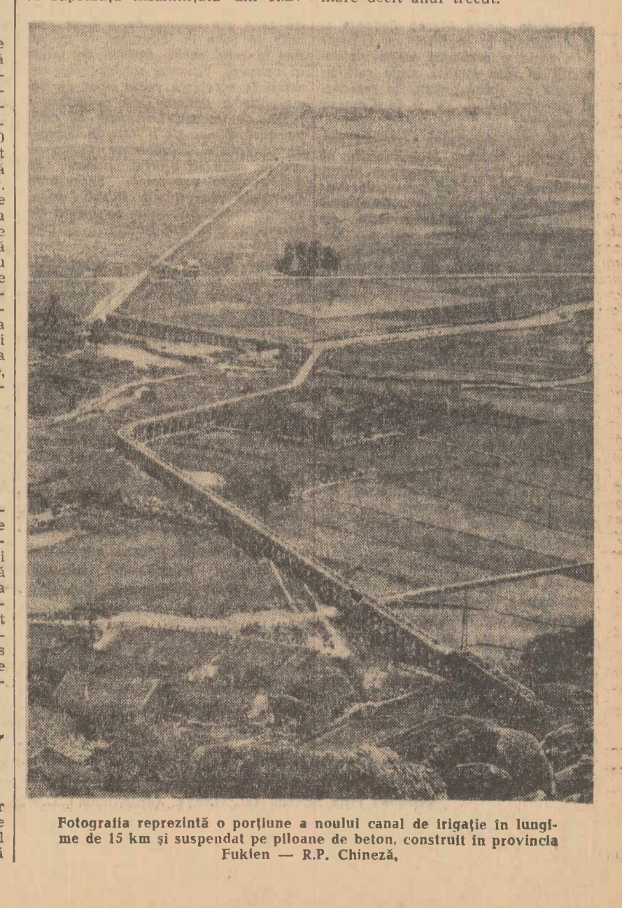
Fotografia reprezintă o porțiune a noului canal de irigație în provincia Foklen — R.P. Chineză, de 15 km și susținut pe piloane de beton, construit în lungime
