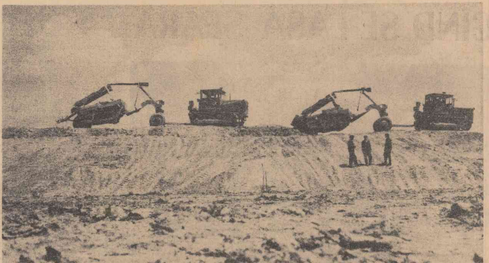
În incinta „Brațușul de Sus” s-a construit un dig care apără de inundații 12.000 de hectare. În prezent, se fac lucrări de completare a digului Foto: AGERPRES
