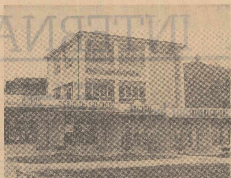
În cartierul Prund din Brașov s-a deschis de curând un complex al cooperărilor meșteșugărești cu secții de frizerie, croitorie, coafură, foto, radio-televiziune etc.
