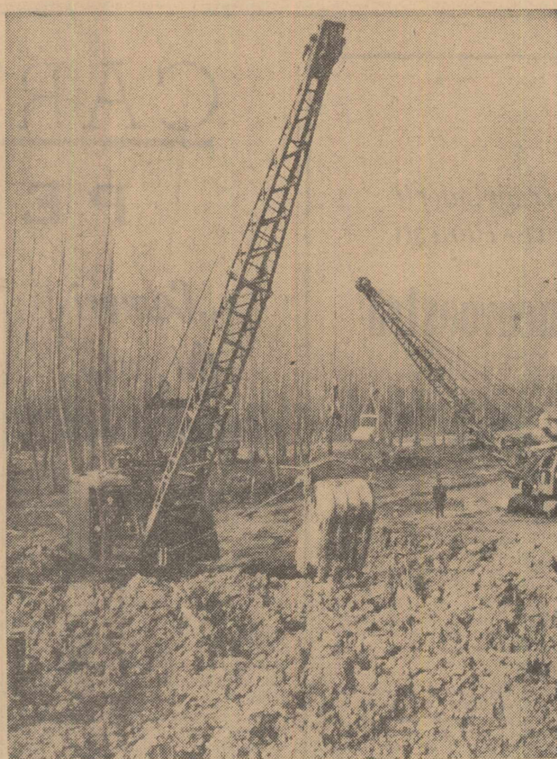
Dragline săpind la canalul principal de evacuare a apelor lacului Greaca
