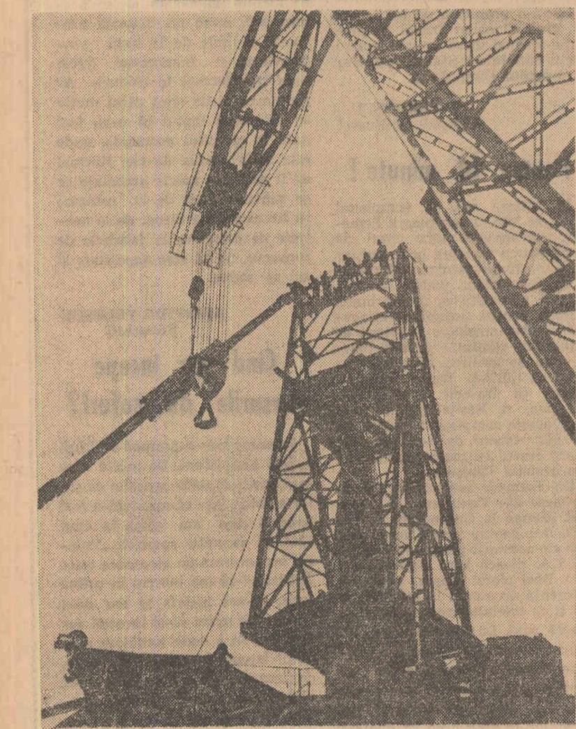
În vederea extinderii portului Constanța în larg se construiesc un mare dig. În ciuseu: Una din urșițele macarale folosite pentru transportul bolovanilor de piatră
