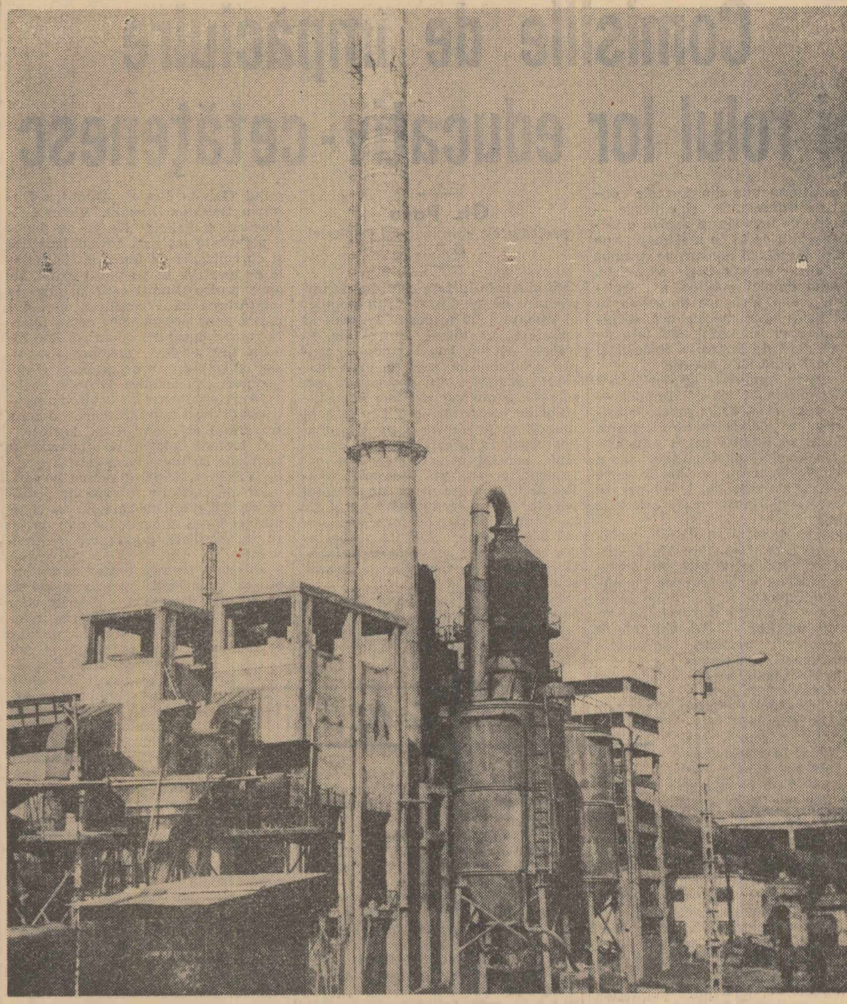
Constructorii și montorii de pe șantierul Fabricii de produse refractare de la Alba Iulia, cea mai mare și mai modernă unitate de acest gen din țară, au intrat în etapa pregătirilor pentru începerea primelor probe tehnologice. În aceste zile activitatea de pe șantier este îndreptată mai ales către inițialul obiectiv al fabricii: linia de șamotă. Foto: S. STEINER
